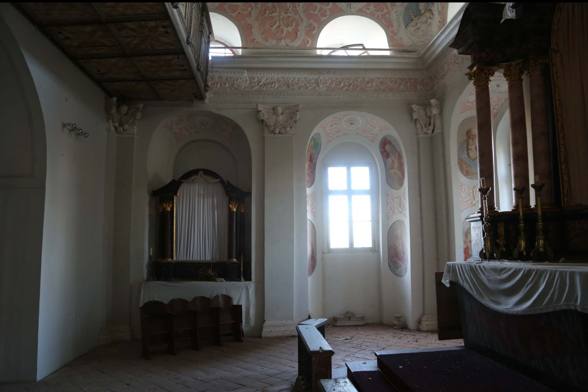
Poškodovano okno v grajski kapeli in posledice gnezdenja ptic
